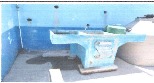
Foto 5: SUSTITUCION DE PILA
