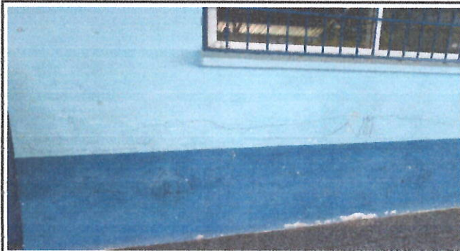
Foto 1: PINTURA EN MUROS INTERIORES Y EXTERIORES
